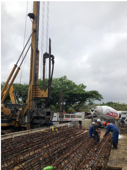
Foto 2: Execução das estacas hélice contínua no CICS.
