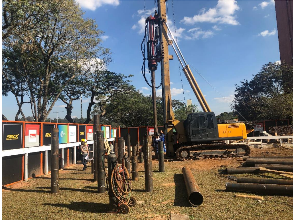
Foto 3: Cravação das estacas tubulares da TUPER no CICS.
