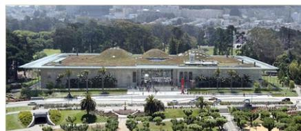
**Figura 6** - Califórnia Academy of Sciences – com 60.000 células fotovoltaicas, auto suficiente em energia, com 10.000m<sup>2</sup> de “telhado verde” e luz natural em 90% dos espaços ocupados.
