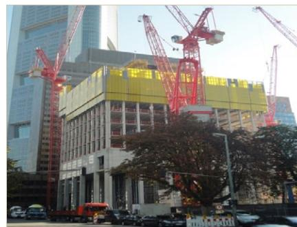
**Figura 7-** Uso intensivo de equipamentos e de proteções passivas de segurança com placa de proteção - Frankfurt – Alemanha (foto do autor)
